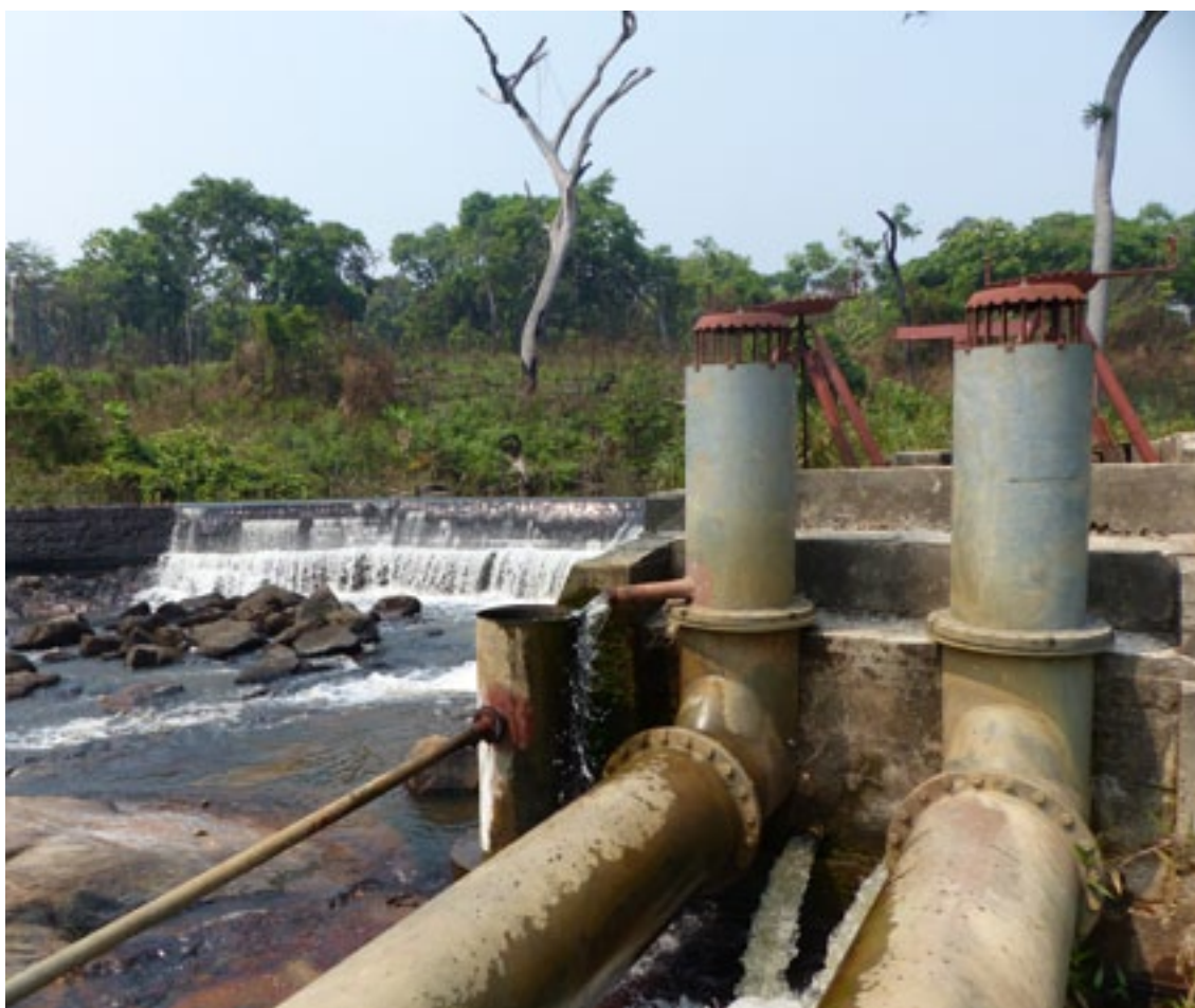
La diga costruita per il progetto ELKAP con le condotte d'acqua che alimentano le turbine.
